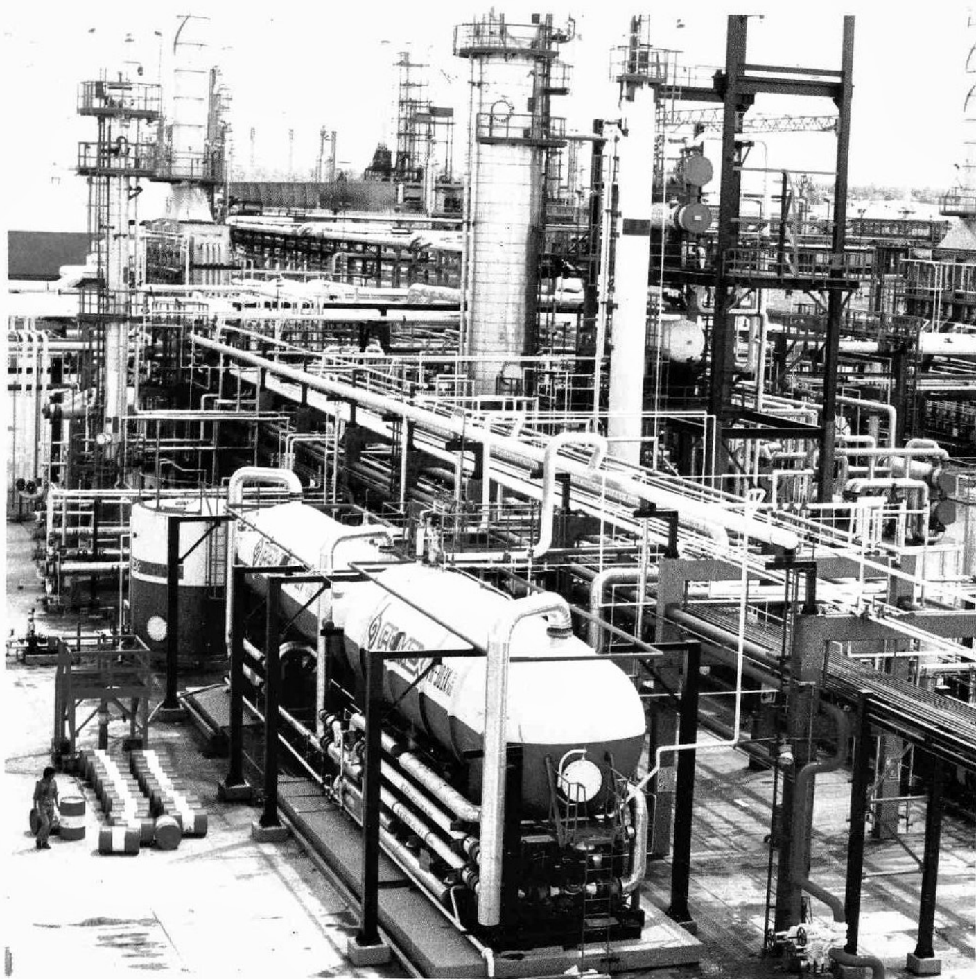
Planta estabilizadora de gasolina y su integración a las plantas primarias y de alto vacío No. 2.
