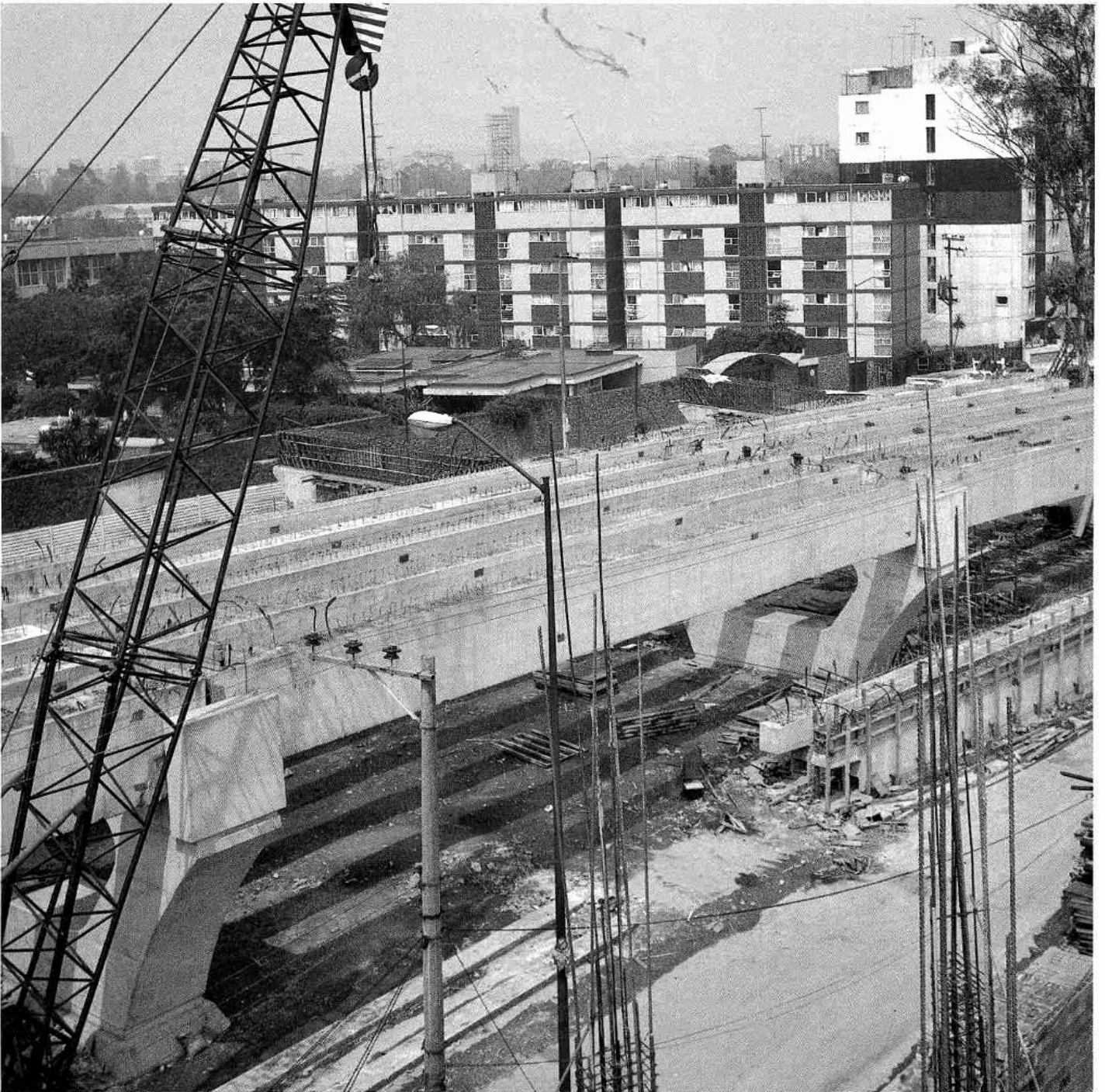
Vista panorámica de la construcción.
